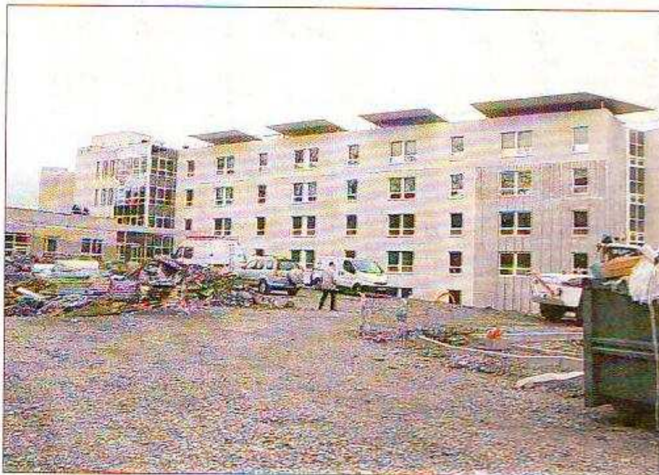
Les travaux de la résidence Léon-Roubeyrol, qui remplacera l'actuel établissement de Boisvignal, devraient être terminés en février, pour un déménagement au mois d'avril.
