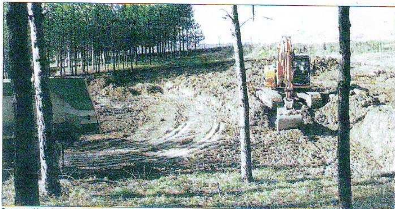
Terrassement important pour un bâtiment semi-enterré.
